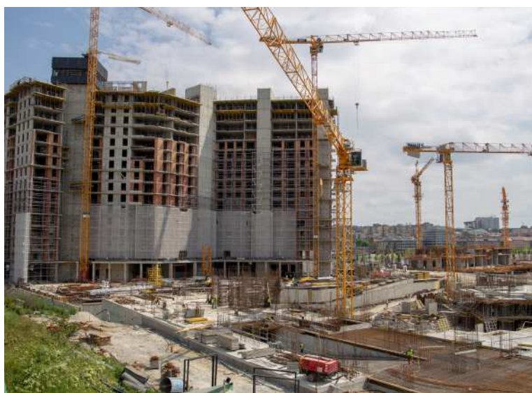
Chantier de construction
